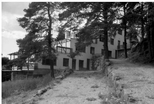
Рис.2. Террасный жилой дом в Кауттуа
