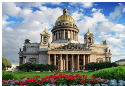
Рис. 7. Исаакиевский собор в Петербурге. Архитектор О. Монферран
