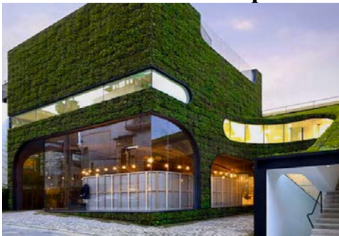
Рис. 3. Строительство "Зеленых домов"
