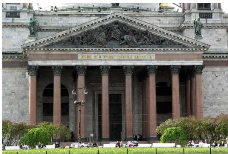
Рисунок 2 – Портик Исаакиевского собора. Суровую мощь розовых гранитных колонн подчеркивают стены собора, облицованные серо-белым мрамором. Каждая из 48 колонн - высота 17 м, диаметр - 1,85 м, весит - 114 т.
